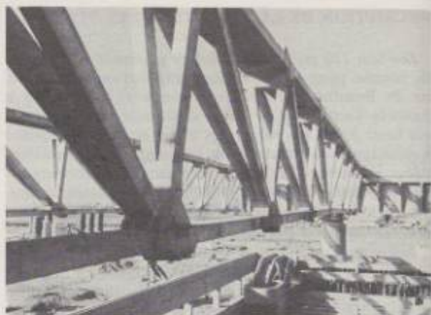
FIG. 2 — Stade de Téhéran. Détail des poutres treillis.
