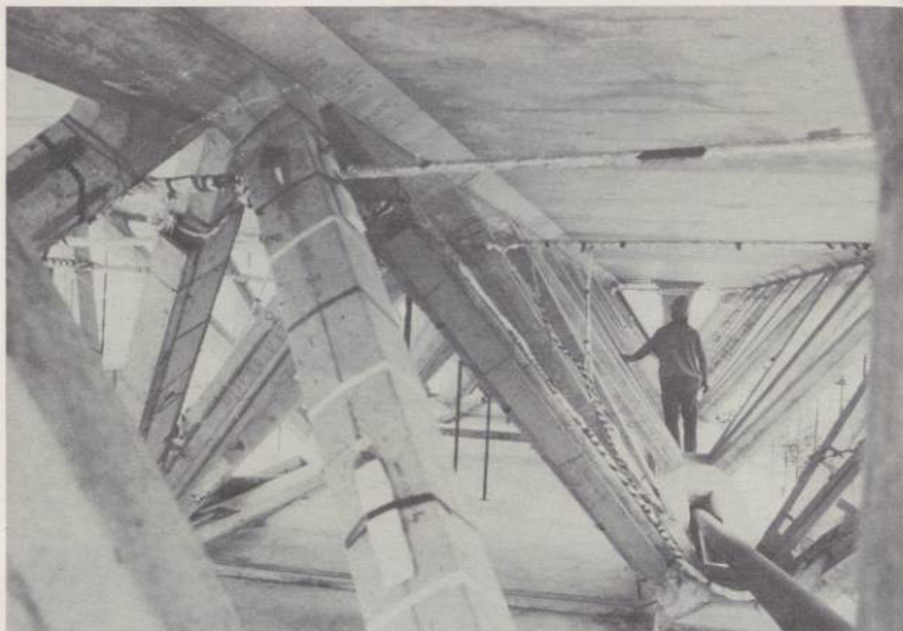
FIG. 6 — Maquette échelle 1. Détail de treillis spatial.
