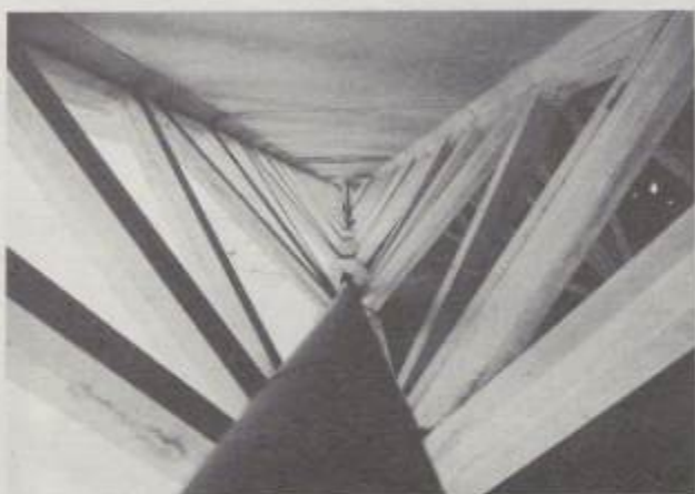
FIG. 4 — Pont de Bubiyan. Détail du treillis spatial.
